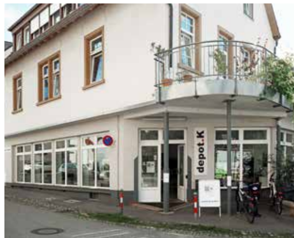
depot.K e.V. Kunstprojekt Freiburg, Hauptstraße 82, 79104 Freiburg
