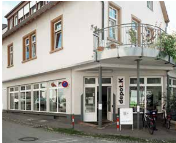
depot.K e.V. Kunstprojekt Freiburg, Hauptstraße 82, 79104 Freiburg
