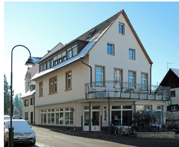
depot.K e.V. Kunstprojekt Freiburg, Hauptstraße 82, 79104 Freiburg
